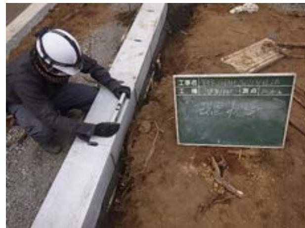
道路改良工事の排水設備(側溝)の新設の様子
