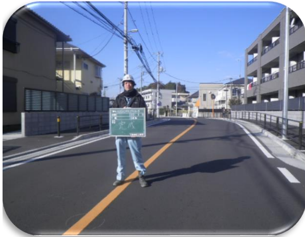
市道長沢53号線道路改良工事
