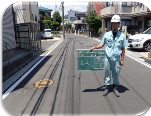
上の宮二丁目ほか2か所口径 100mmから150mm配水管布設替工事
