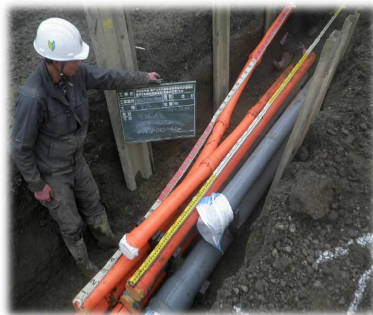
電線共同溝地中化工事の様子
