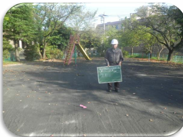
白鳥東公園ほか広場補修工事
