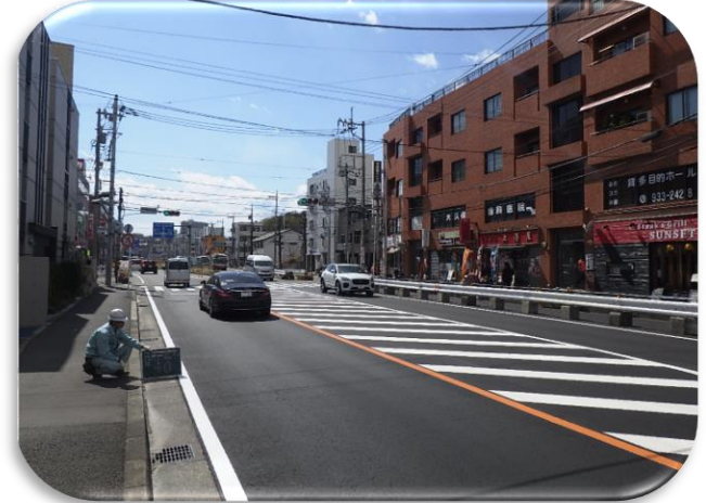
多摩区内都市計画道路世田谷町田線 道路築造(登戸交差点)工事
