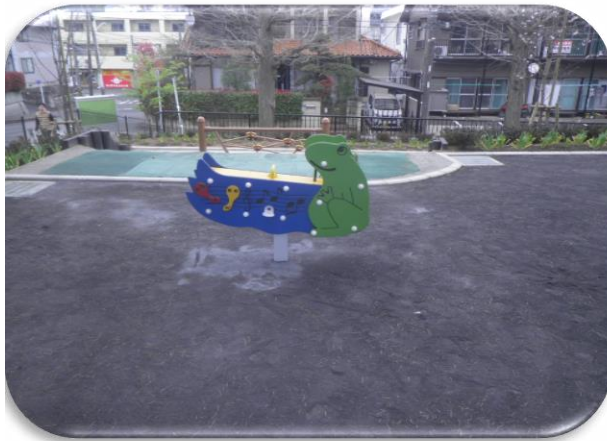
菅生第3公園ほか2公園整備工事
