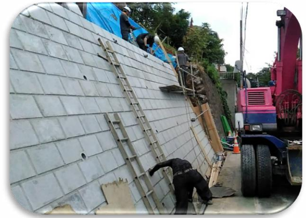
五所塚間知石設置工事
